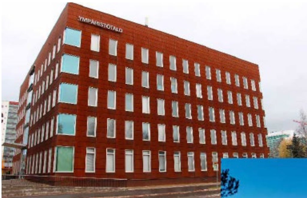
Till fasaden på Uleåborgs stads Miljöhus har man valt miljövänligt COR-TEN A-stål.
