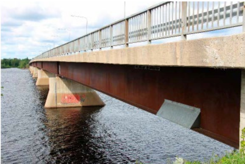
Finlands längsta bro tillverkad av väderbeständigt stål 1975. Bron ligger i Tervola.
